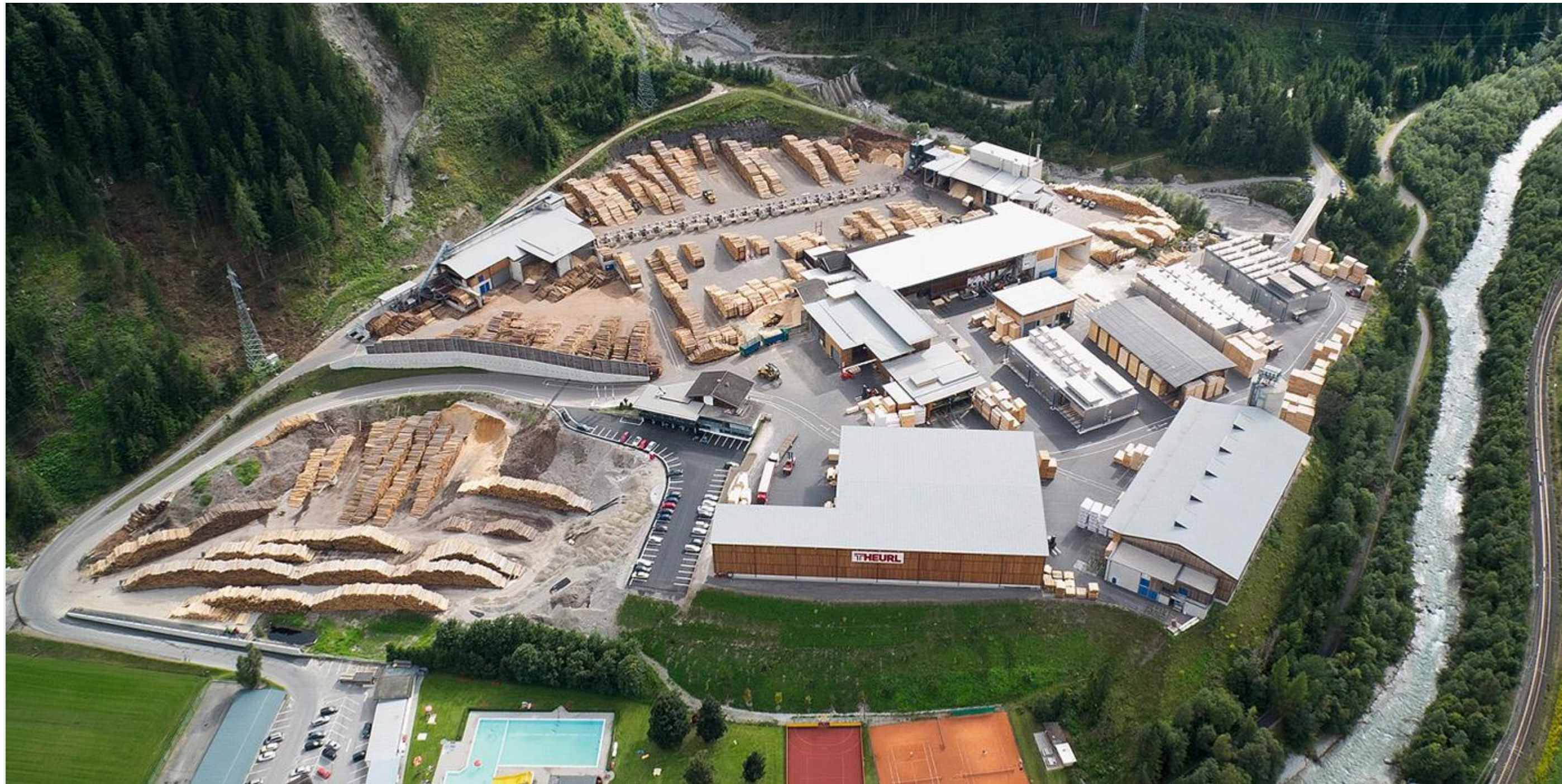
Rund 200 Mitarbeiter beschäftigt der Holzindustriebetrieb Theurl in Assling. Fotos: Fa. Theurl
