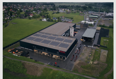
STANDORT STEINFELD/KÄRNTEN CLT Werk · Abbundservicezentrum
