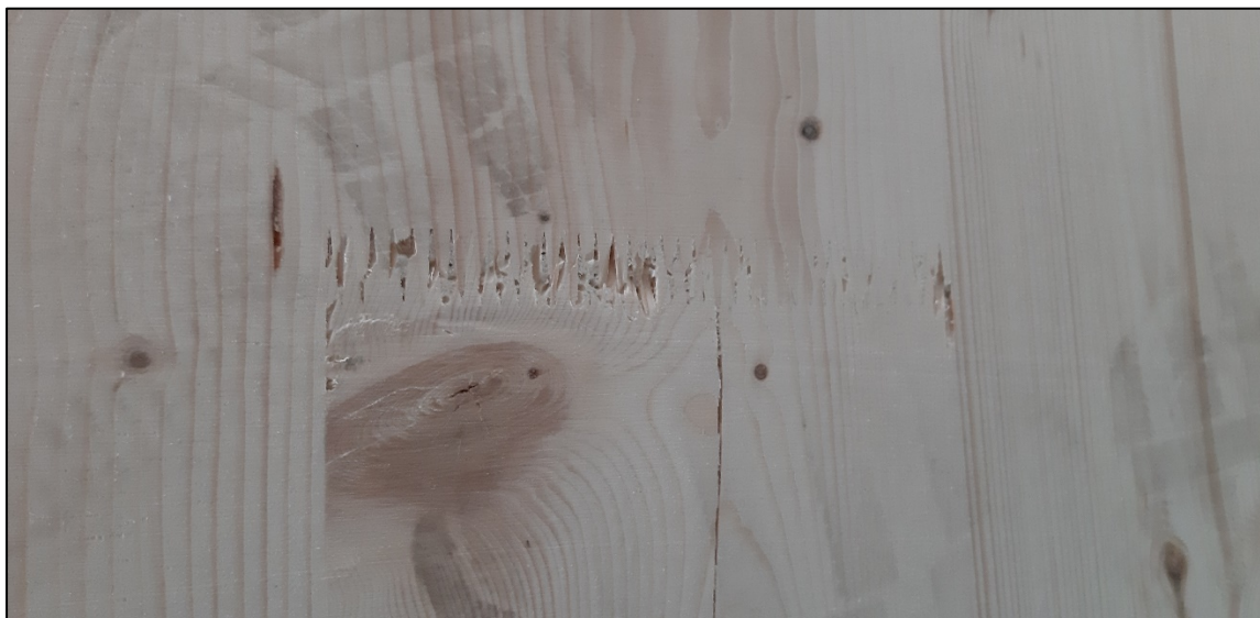
Figura 1: Scheggiatura di una giunzione a pettine e fessura adiacente sul Campione di prova 1
